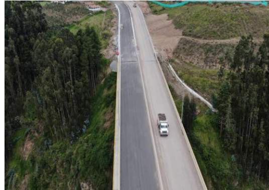
Viaducto Boqueron (Diciembre 2021)
