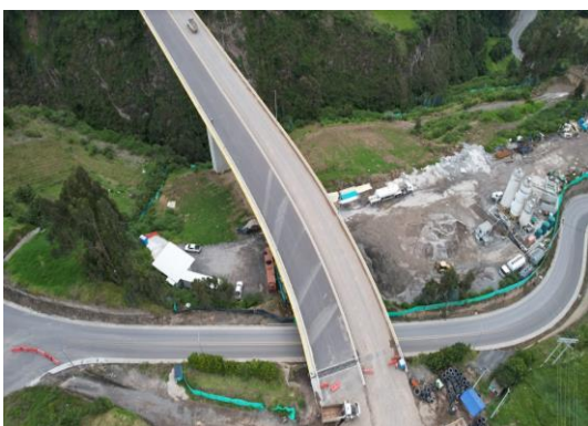
Viaducto Boquerón – Vista general
