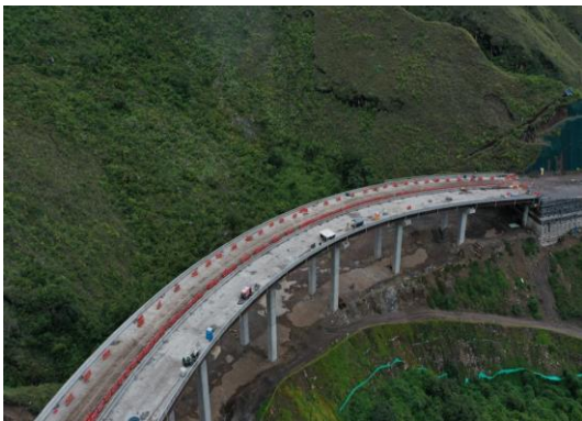
Viaducto Tablón Alto (Marzo 2021)
