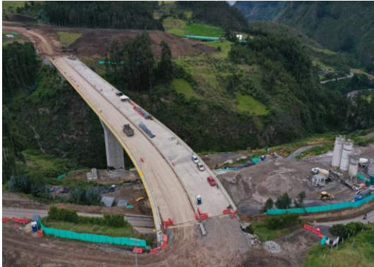
Viaducto Boqueron (Marzo 2021)
