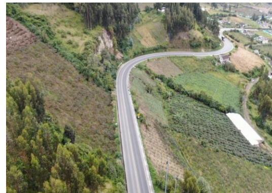
Tramo Rehabilitación - PK 14+500
