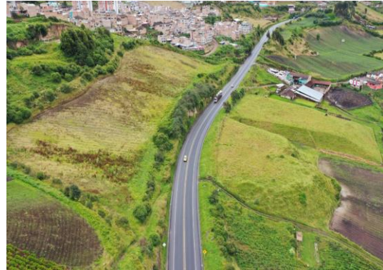
Tramo Rehabilitación - PK 4+500
