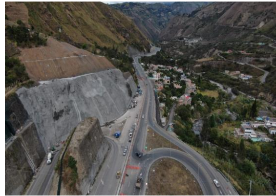
CO313 Tratamiento de talud
