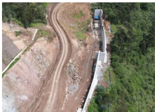
TR178-Muro en Concreto
