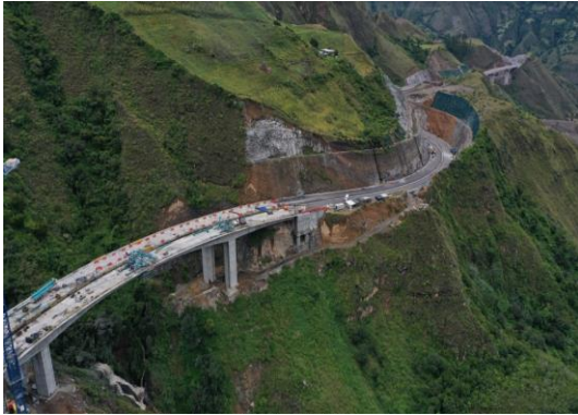
Viaducto Macal (Marzo 2021)
