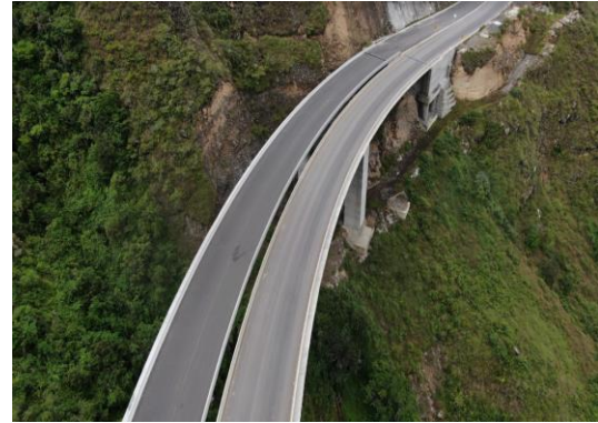
Viaducto Macal (Diciembre 2021)
