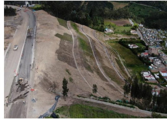
Z1-14B Tratamiento de talud
