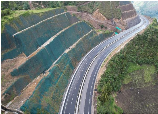
CO218 Tratamiento de talud
