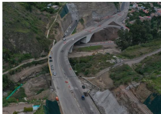
Viaducto Sapuyes (Diciembre 2020)
