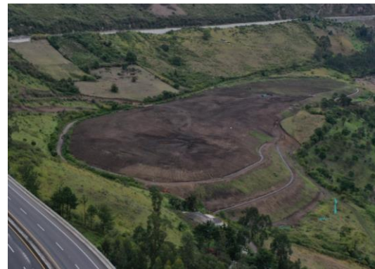
Z4-7 Tratamiento de talud
