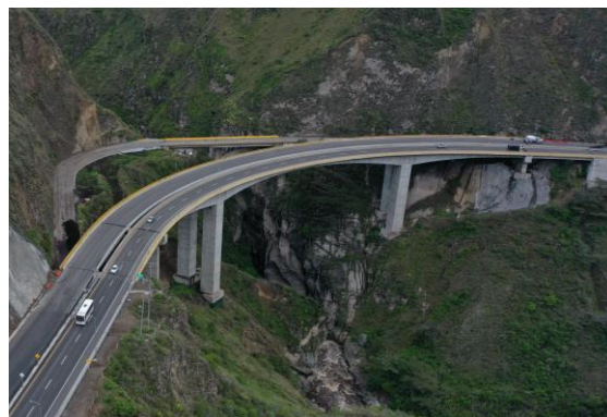
Viaducto Guaitara (Diciembre 2020)
