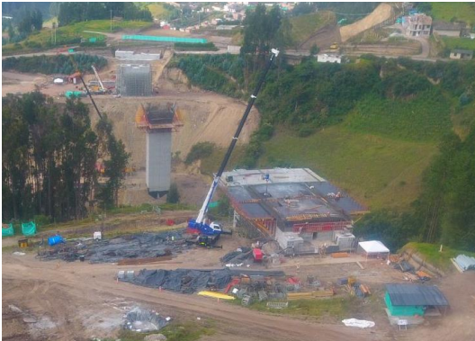
Viaducto Boqueron (Marzo 2020)
