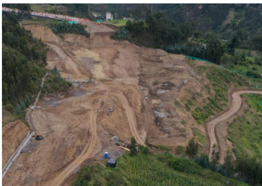
TR171 Terraplén núcleo
