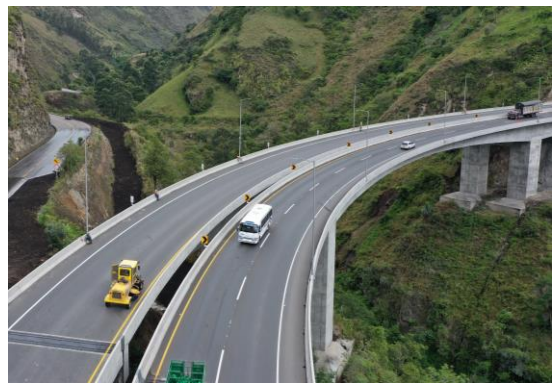
Viaducto Magdalena (Diciembre 2020)
