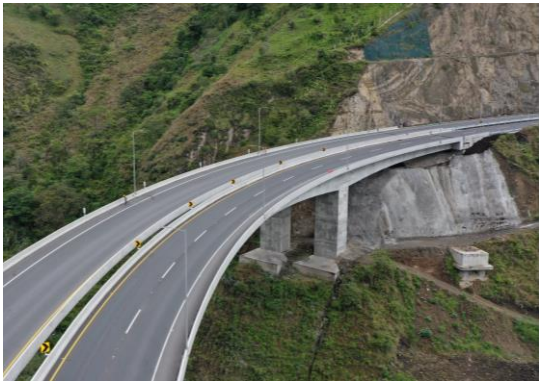
Viaducto Magdalena – Vista general
