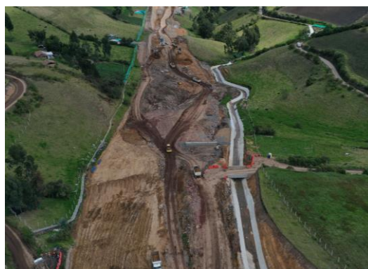
TR209 Terraplén núcleo
