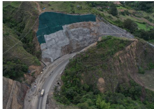
CO306 Tratamiento de talud
