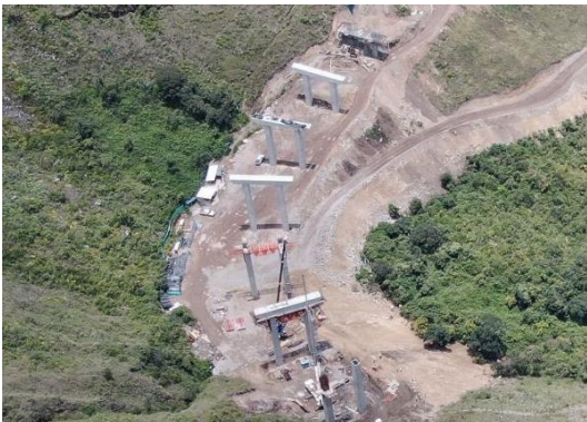
Viaducto Tablón Alto (Marzo 2020)
