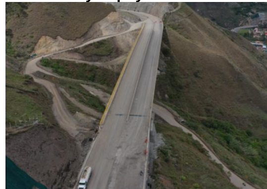
Viaducto Sapuyes (Diciembre 2020)
