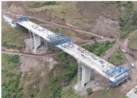
Viaducto Porvenir (Marzo 2020)
