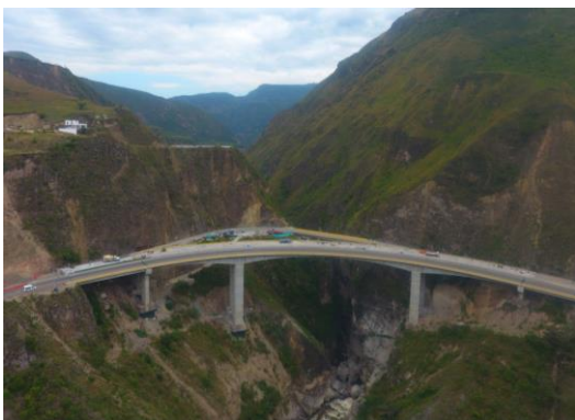
Viaducto Guaitara (Marzo 2020)
