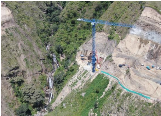
Viaducto Macal (Marzo 2020)
