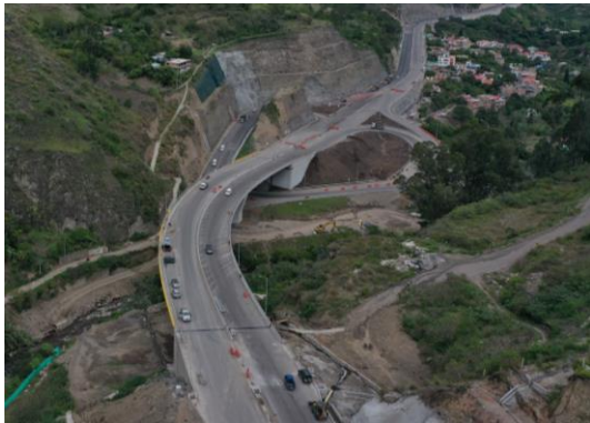
Viaducto Sapuyes – Vista general
