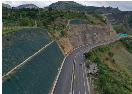
CO410 Tratamiento de talud
