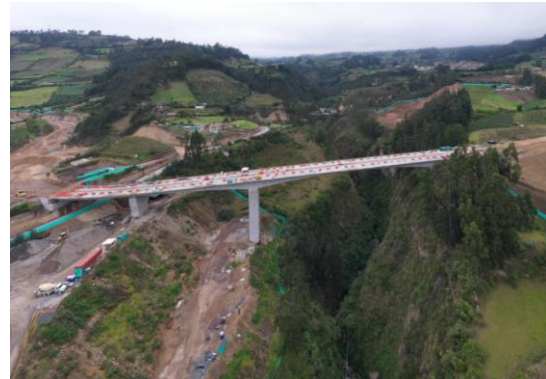
Viaducto Boqueron (Diciembre 2020)
