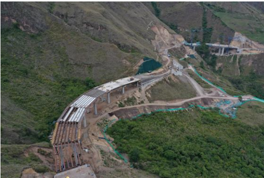
Viaducto Tablón Alto – Vista general
