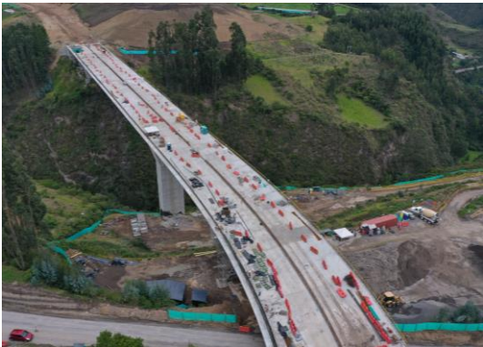
Viaducto Boquerón – Vista general
