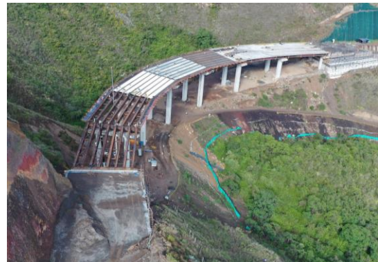
Viaducto Tablón Alto (Diciembre 2020)
