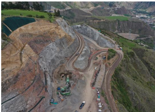
CO228 Vista General
