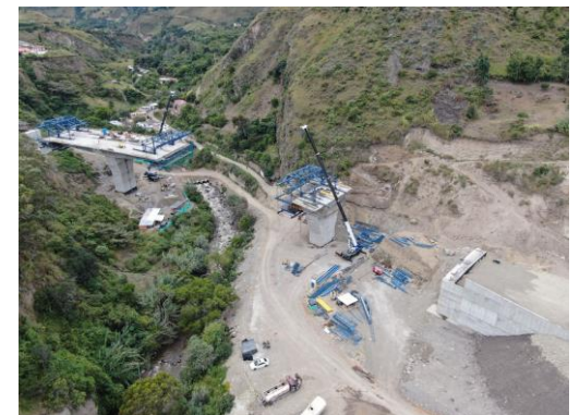
Viaducto Sapuyes (Marzo 2020)
