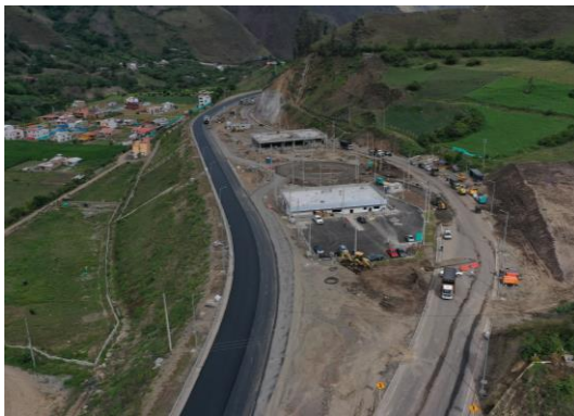
TR307 Tratamiento de talud
