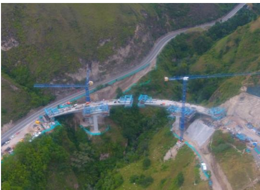
Viaducto Magdalena (Marzo 2020)
