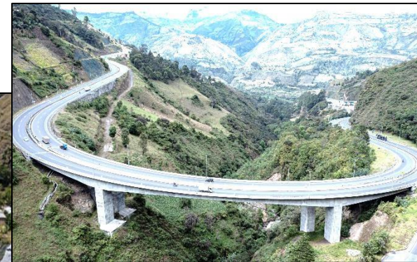
Magdalena UF4 Longitud: 194 m (calzada derecha) 183 m (calzada izquierda)
