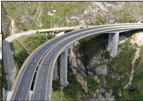
Guáitara UF4 Longitud: 310 m (calzada derecha) 300 m (calzada izquierda)
