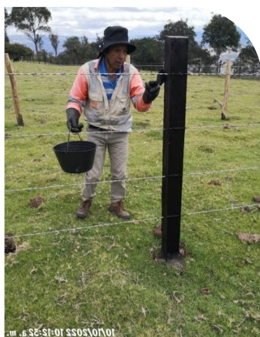
Fecha: octubre 2022 Localización: El Tablón (Polígono 7) Descripción: Impermeabilización de postes
